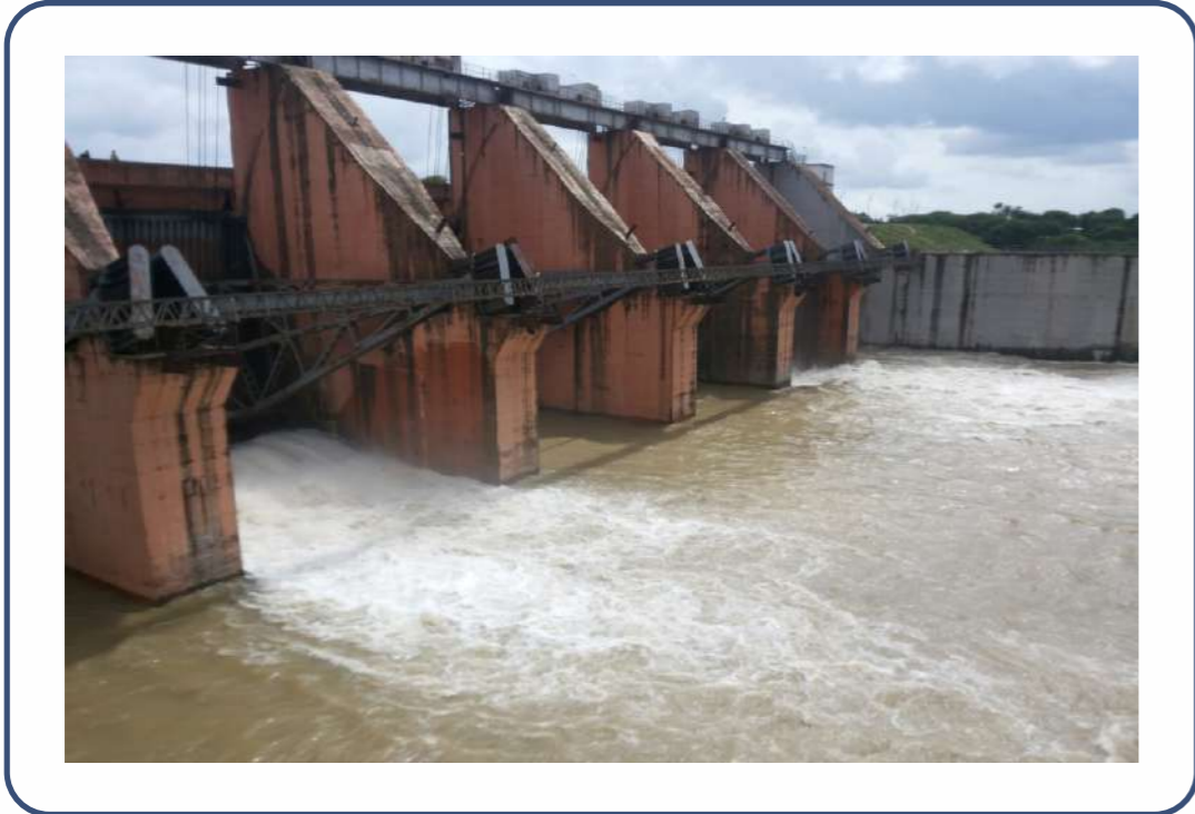
Ujani dam उजनी धरण
